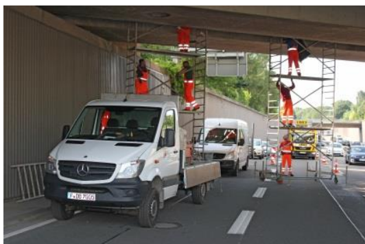
Gerüstbau – gesperrte Spur 1 + 2
