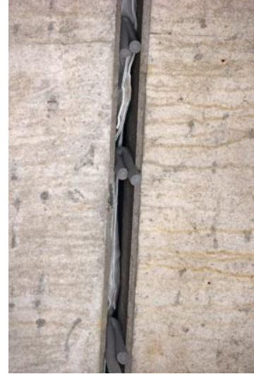
11:00 Uhr Beide Kissenenden in Spur 3 etwa 0,5 m überlappt in Fuge und mit PE-Rundschnur gesichert
