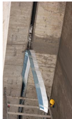
10:15 Uhr Fugenfüllmasse in Spur 3 entfernen
