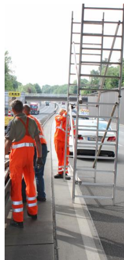
10:15 – 10:30 Uhr Gerüst umsetzen von Spur 1 nach Spur 4 und Spur 2 nach Spur 3
