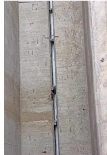
Druckbefülltes Abdichtkissen mit PE-Rundschnur
