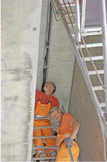
Anbringen der Schutzfolie F-SVS-QADK/V gegen Wasserfortleitung im Überlappungsbereich von zwei Abdichtkissen
