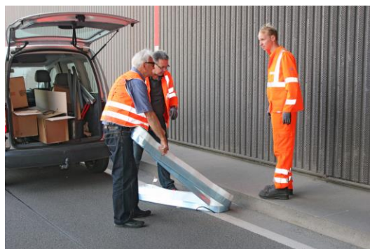
Abdichtkissen 21.3 SVS-QADK/V L Länge 23 m umwickeln, damit das Ventilende am Anfang ist
