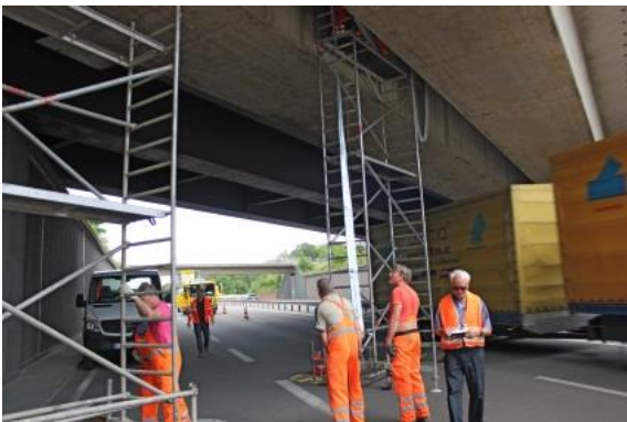
11:28 – 11:45 Uhr Gerüstumbau von Spur 3 nach Spur 6. Abdichtkissen in Spur 4 befestigt.
