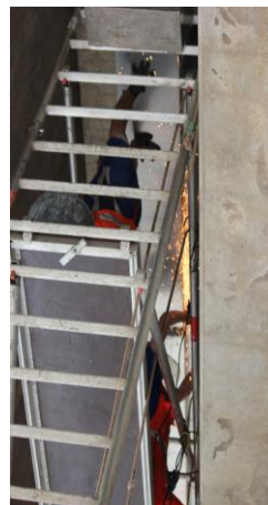
10:30 – 11:00 Uhr Rückbau der Alu-Blechschutzverkleidung Spur 4
