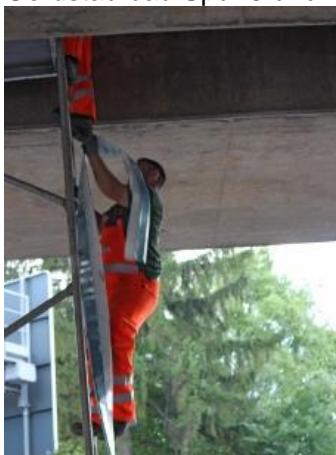
Gerüstaufbau Spur 3 und 4
