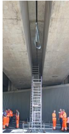
10:00 Uhr Abdichtkissen zwischen Spur 2 und 3 mit der Quersicherung befestigt.
