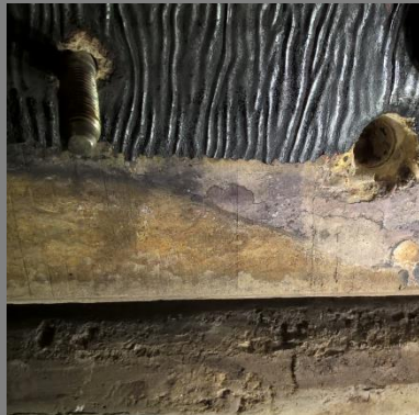
Bohrlöcher verschließen
