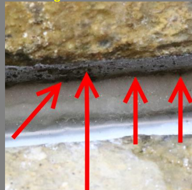
Abgeplatzte Betonüberdeckung ausbessern !
