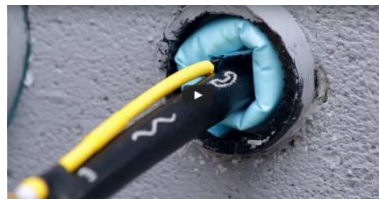
Montage Kabelrohrabdichtung \varnothing \leq 60 mm
